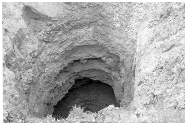
Рис. 1. Зарождение новой карстовой воронки, образующейся в процессе эксплуатации газопровода
